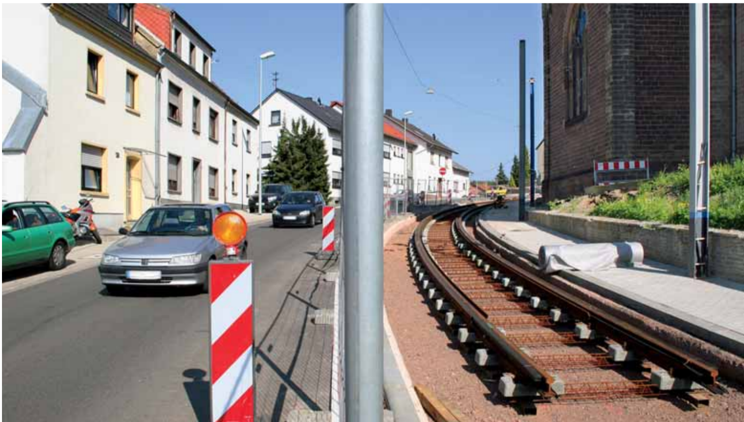
Gleisarbeiten in der Saarbrücker Straße
