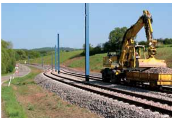
Abschließende Arbeiten im Russenweg
