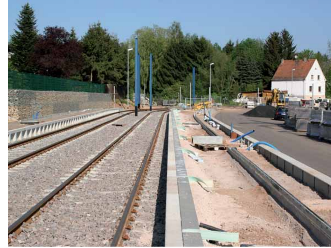
Im Russenweg stehen bereits die Oberleitungs Masten (im Bild: Haltestelle Gisorstraße)
