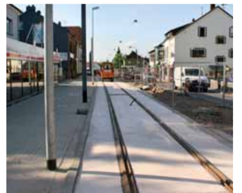
Trasse und Gehweg in der oberen Saarbrücker Straße
