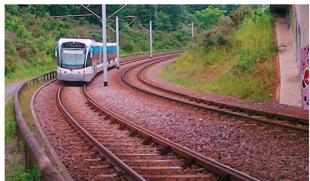
Bahn im Bogen mit Überhöhung
